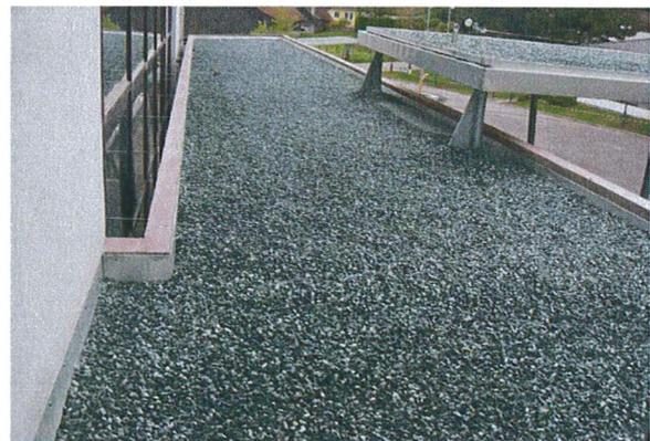
Également ancré dans le mur qui à l'occasion de ces travaux est restauré, le toit préfabriqué en bois et étanché sera recouvert de gravier concassé.
